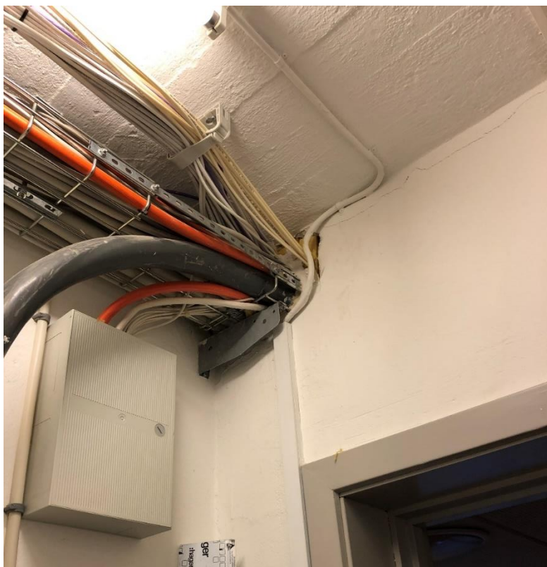
Figur 5: Manglende brandmæssig tætning af kabelbakker.
